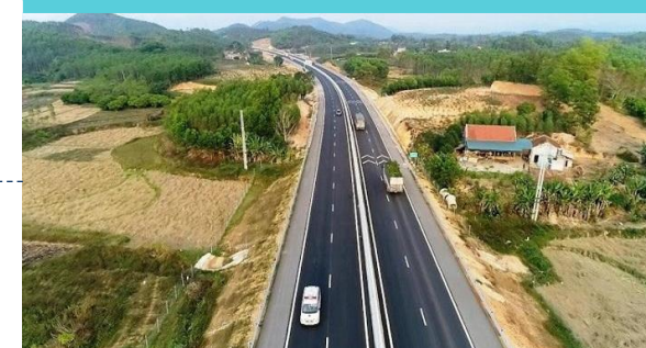
Nâng cấp QL4B đoạn km 3+700 - km 18 - Lạng Sơn
